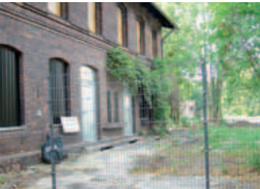
Cordesstraße – zugenanagelt unter Denkmalschutz
